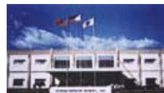
Hitachi Air Conditioning, Филиппины
