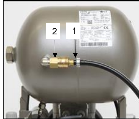
Obr. 4: Pripojenie k výstupu stlačeného vzduchu
