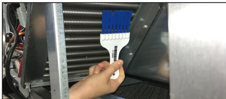
Рис. 3. При чистке не допускается вести щетку поперек ребер.
