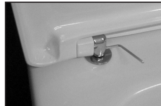
09 Stringere con la chiave in dotazione (brucola) la cerniera sul pin di fissaggio. Tighten the hinge on the screw's pin by using the provided key.
