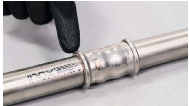
Рис. 33. Проверка пресс-соединения.
