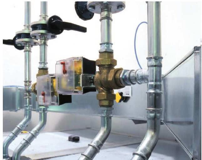
Рис. 22. steelPRES — контур охлаждения.
