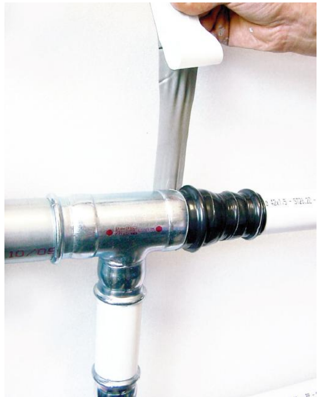
Рис. 38. Защита соединений с помощью бутаноловой клейкой ленты.
