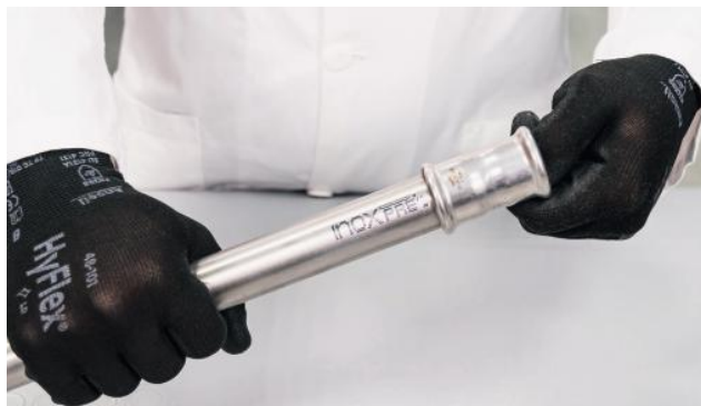
Рис. 31. Вставка трубы в пресс-фитинг.
