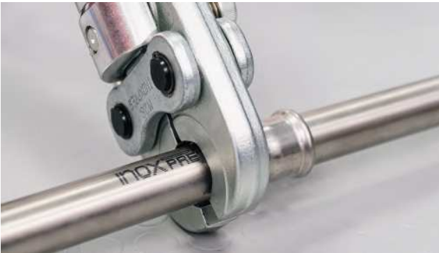
Рис. 32. Опрессовка.
