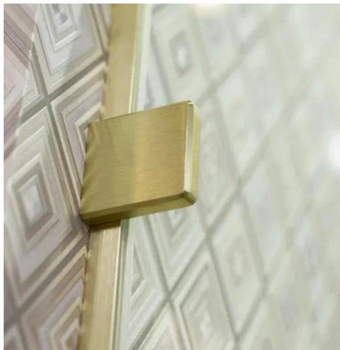
**Дополнительные кронштейны фиксации стекла на профилях** – новое техническое решение, увеличение прочности конструкции
