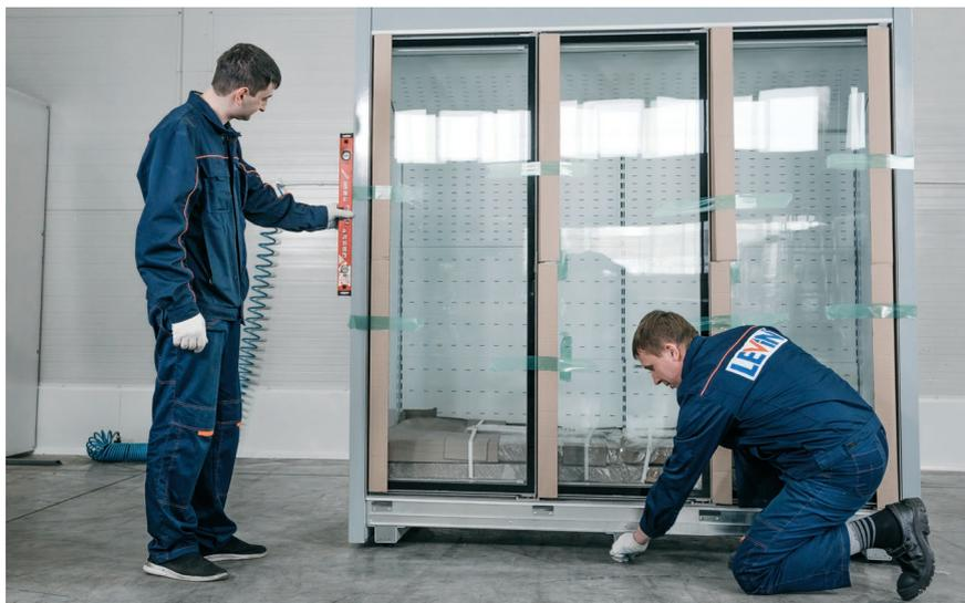
*Рис. 6. Регулировка шкафа по высоте*
