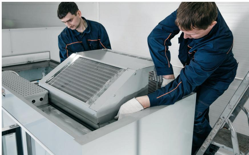
Рис. 10. Закрепление кассетных агрегатов
