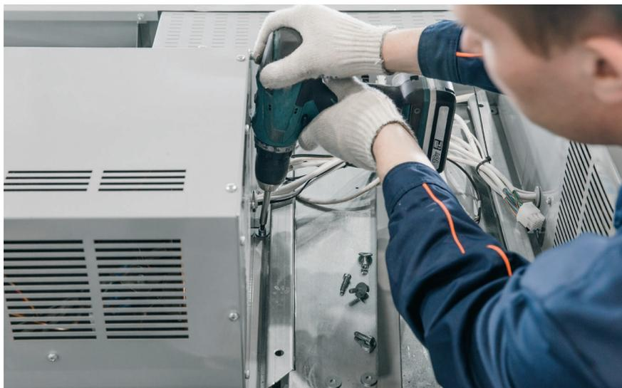
Рис. 11. Подключение кассетных агрегатов к блоку управления
