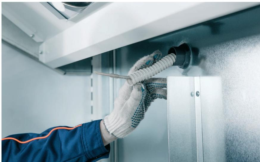
Рис. 14. Монтаж трубки слива конденсата
