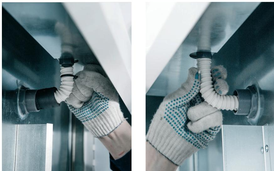
Рис. 15. Подключение ПЭНов подогрева трубки слива конденсата
