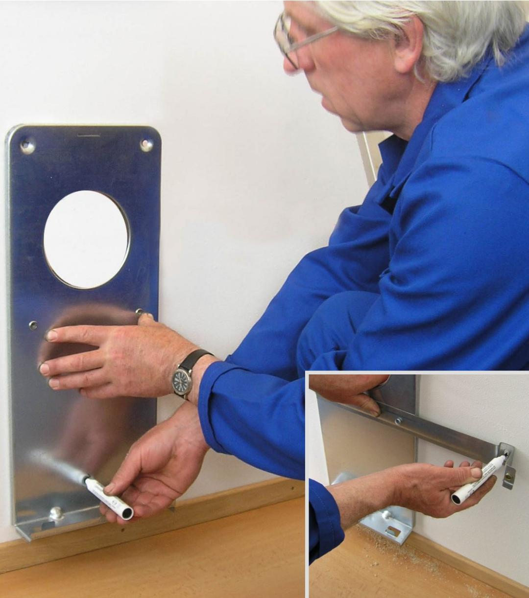
Подвесной лист (БЕТА 2) и подвесной комплект (БЕТА 3,4,5 с подвесной планкой) срисовать на стену и обозначить отверстия для привинчивания и для системы отвода.
