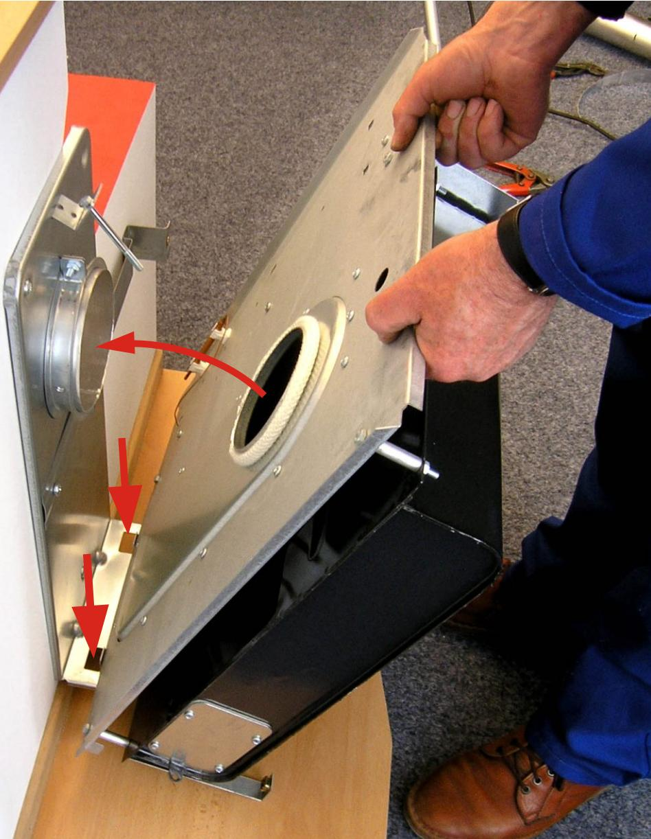
Комплектный отопительный прибор (без крышки) вставить нижней частью в подвесной лист.
