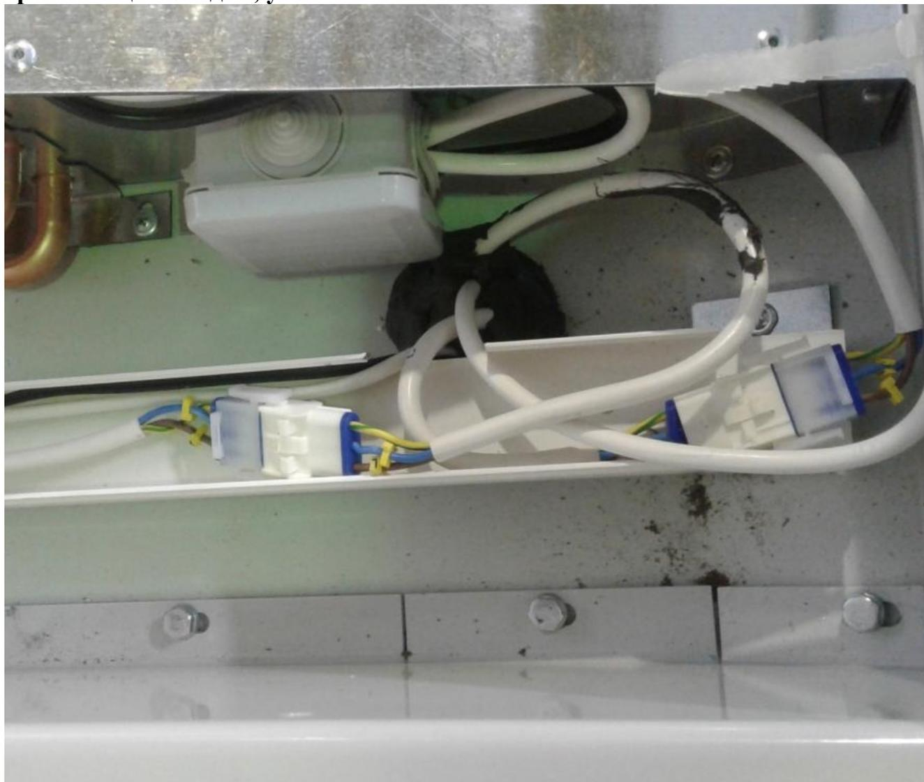
**11. Датчики температуры контроллера и термометра приклеить алюминиевым скотчем к верхней задней панели. Необходимо исключить касания датчиков с металлической обшивкой панели. Стыки задних панелей проклеить алюминиевым скотчем по всей длине с внутренней и наружной стороны.**
