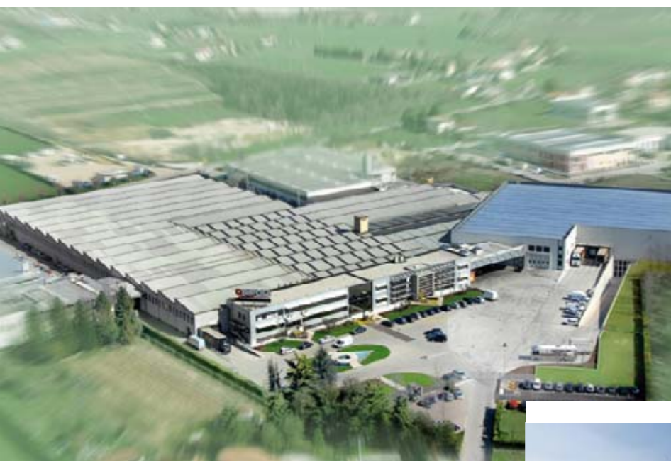
Stabilimento La Nordica Montecchio Precalcino
