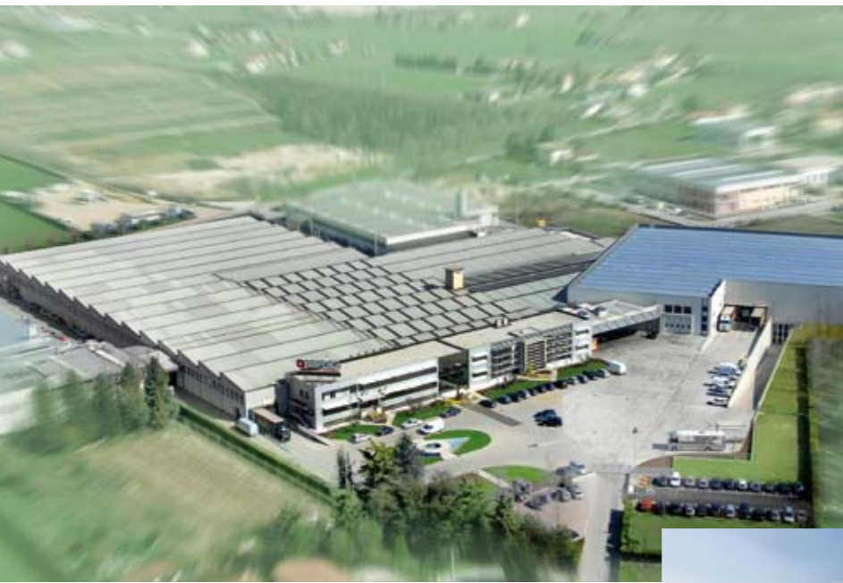
Stabilimento La Nordica Montecchio Precalcino
